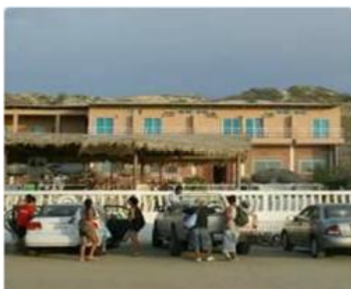
Figura # 2: Fachada de la Hostería Maresol
