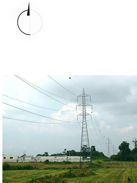
Figura 6. Línea de alta tensión Fuente: Loor (2014)
