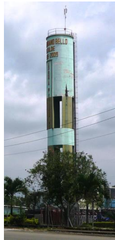
Figura 28. Estación de bombeo - pozo #9 sector Nueva Unión. Fuente: Loor (2014)
