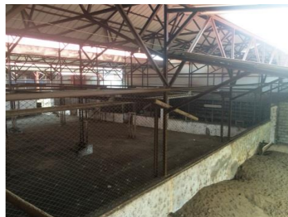
Figura 73. Cerramiento con malla y muros. Fuente: Farías, Ramón, Torres, Zúñiga (2014)
