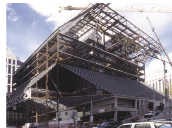
ESTRUCTURA DEL EDIFICIO
