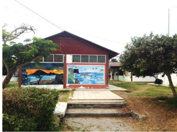
Figura 18: Vista del edificio existente Fuente: Arias ( 2014).
