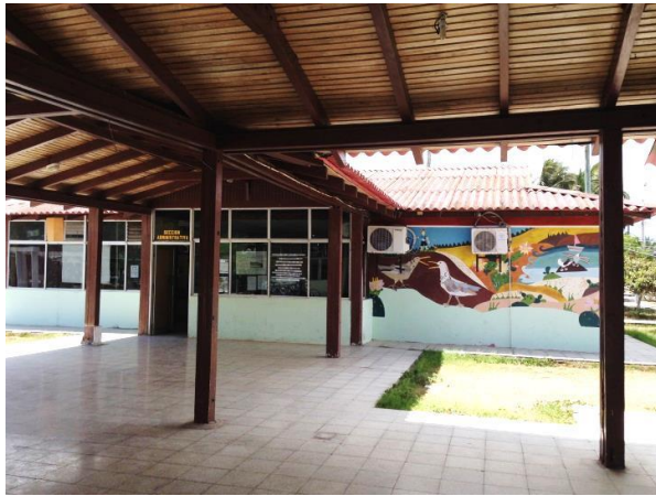
Figura 17: Galería Cubierta Fuente: Arias ( 2014).
