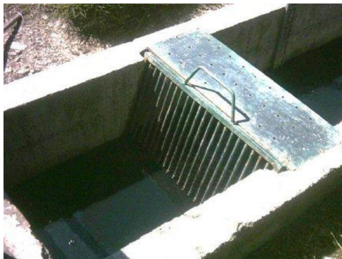
Figura 1. Esquema de una reja de barras (operación de desbaste)
