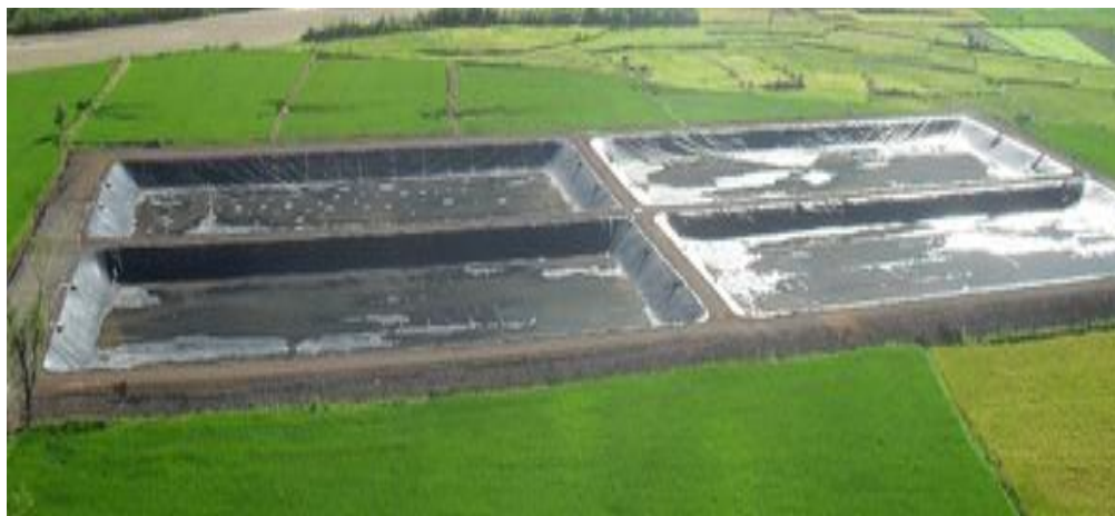
Figura 17. Proceso de impermeabilización en lagunas
