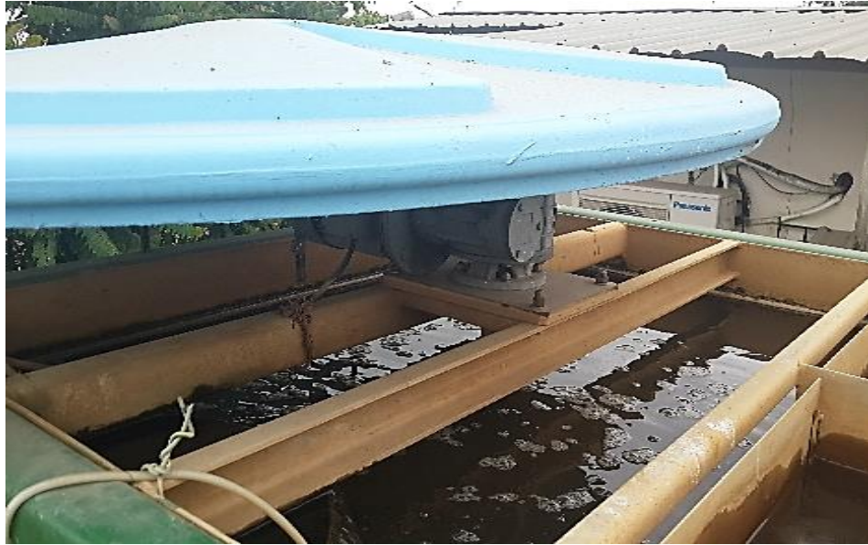
Figura 3. 6 Tanque de mezcla rápida [Fotografía de Yomaira Caicedo]. (Cantón Santa Lucía. 2014).
