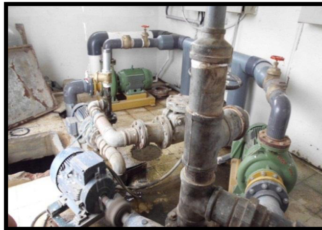
Foto 2.2 Estación de Bombeo de Agua Cruda
