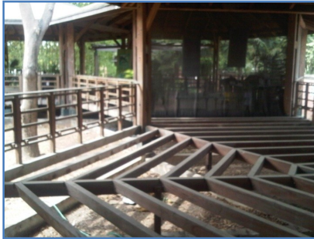
Foto 4 Vista interna del terreno del local.
