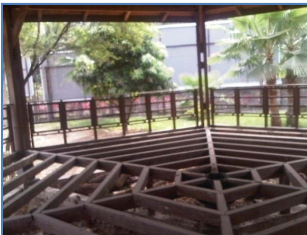
Foto 3 Vista interna del terreno del local.
