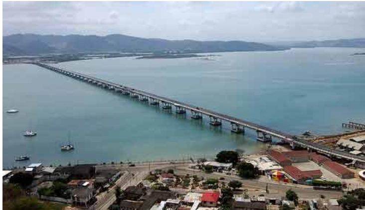
Figura 6. PUENTE LOS CARAS
