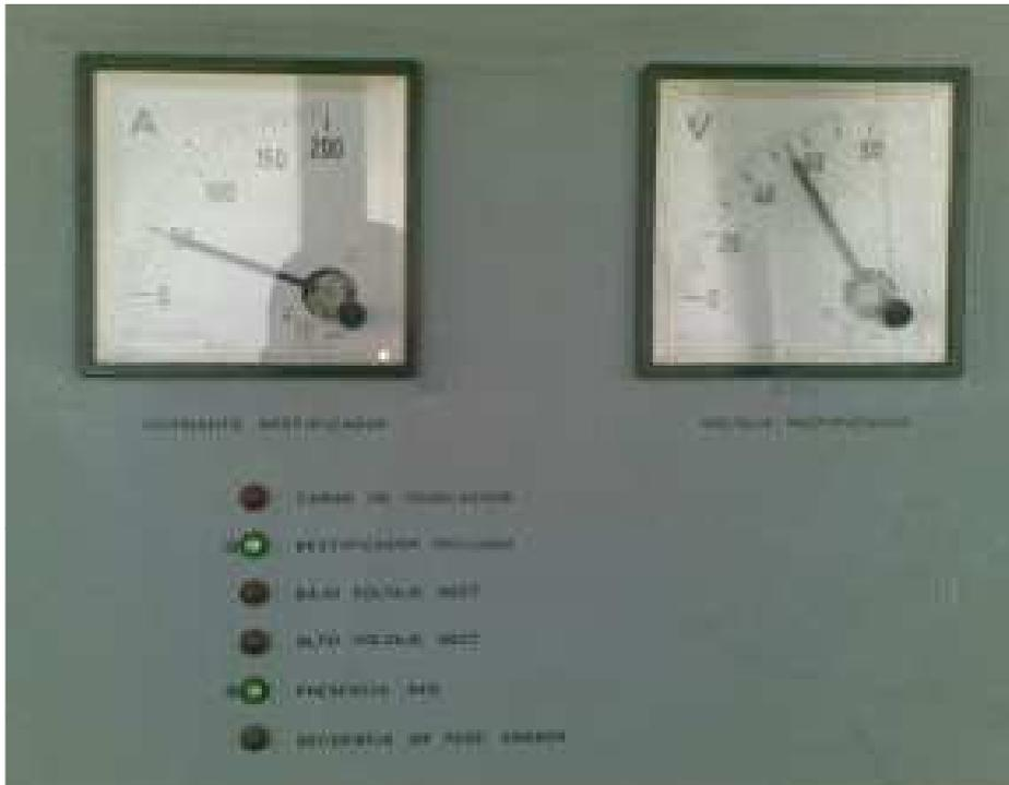
*Figura 2.17 Alarmas de señalización con LEDs del rectificador Braga Moro.*
