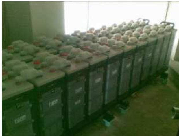
*Figura 2.19 Banco de Baterías Fiamm 1200 Ah, 48 V DC.*
