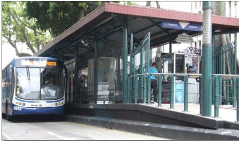
Figura 5: Parada de la Metrovía (Centro de la Ciudad)
