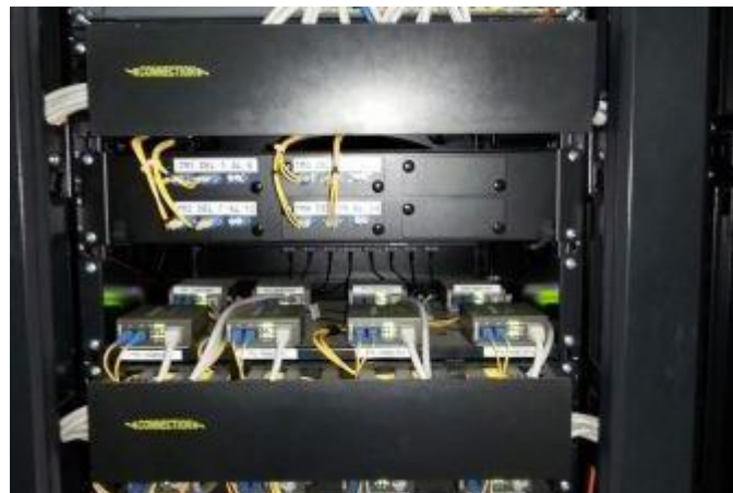
Figura 2.36. Organizadores Horizontales, del tipo raqueable.
