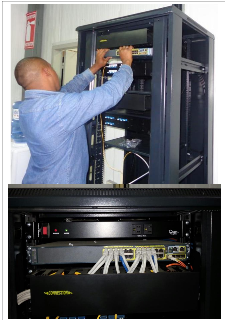
Figura 2.40. Instalación del Switch principal, posterior conexionado.
