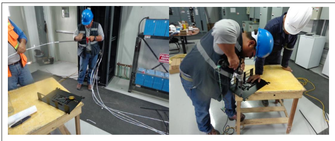
Figura 2.31. Preparación de los cables de FO, preparación de los ODF's principales
