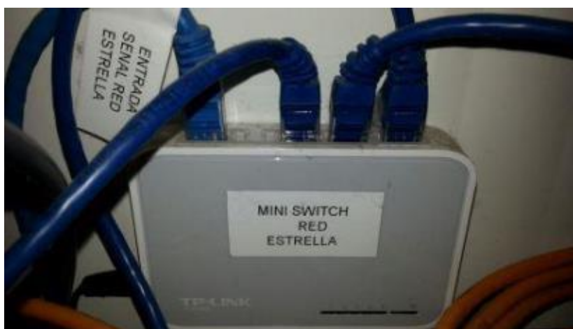
Figura 2.42. Rack armado e interconectado todos sus elementos
