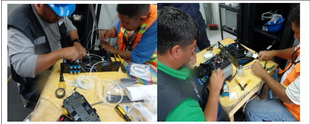
Figura 2.33. Corte, fusión, peinado y armado de ODF principal
