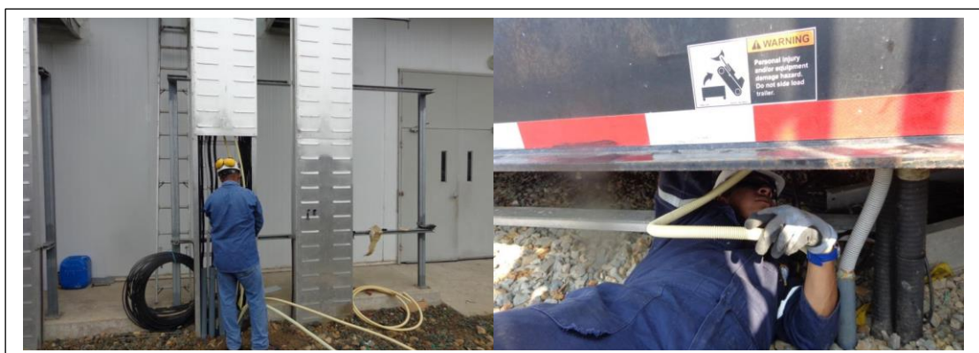
Figura 2.21. Ingreso de la FO hacia el cuarto de control y hacia cada máquina
