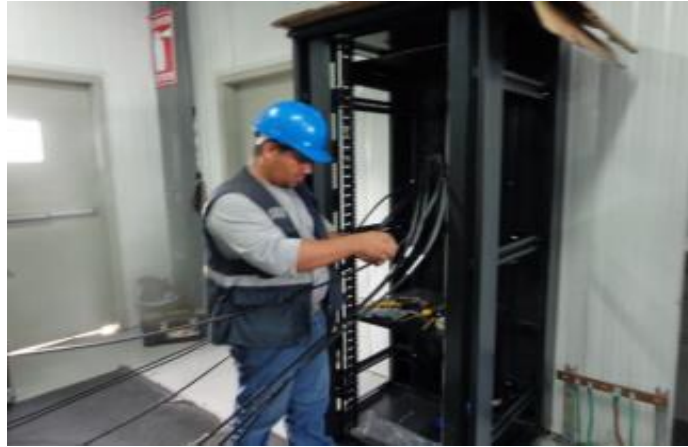
Figura 2.22. Instalación del rack de piso
