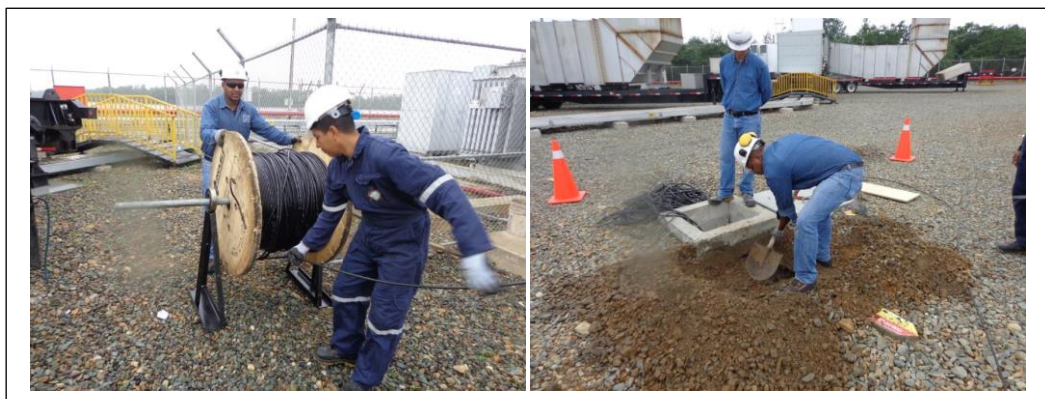
Figura 2.19. Tendido de FO y búsqueda de ductos taponados
