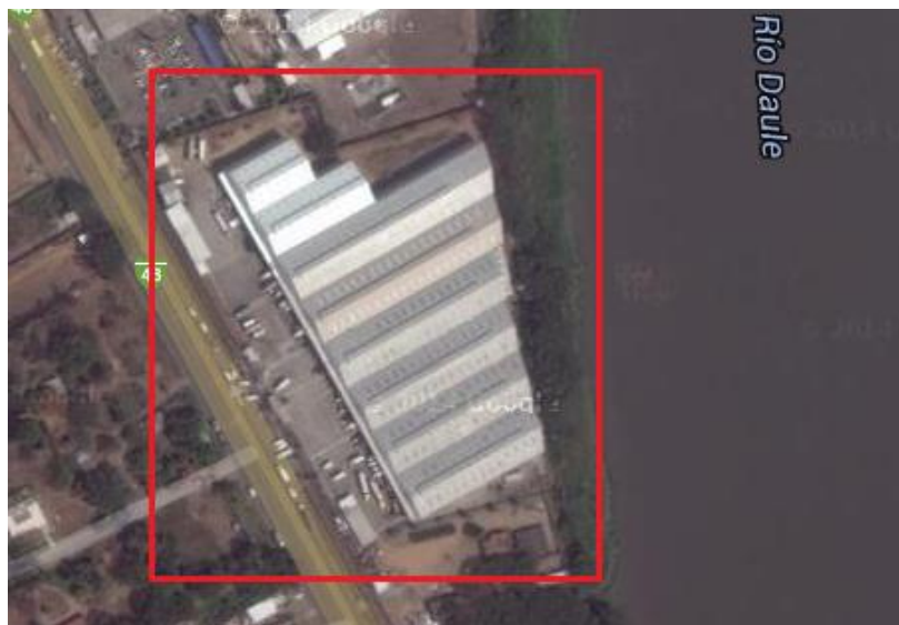
Figura 19 Vista satelital del centro de distribución Tia en Guayaquil
