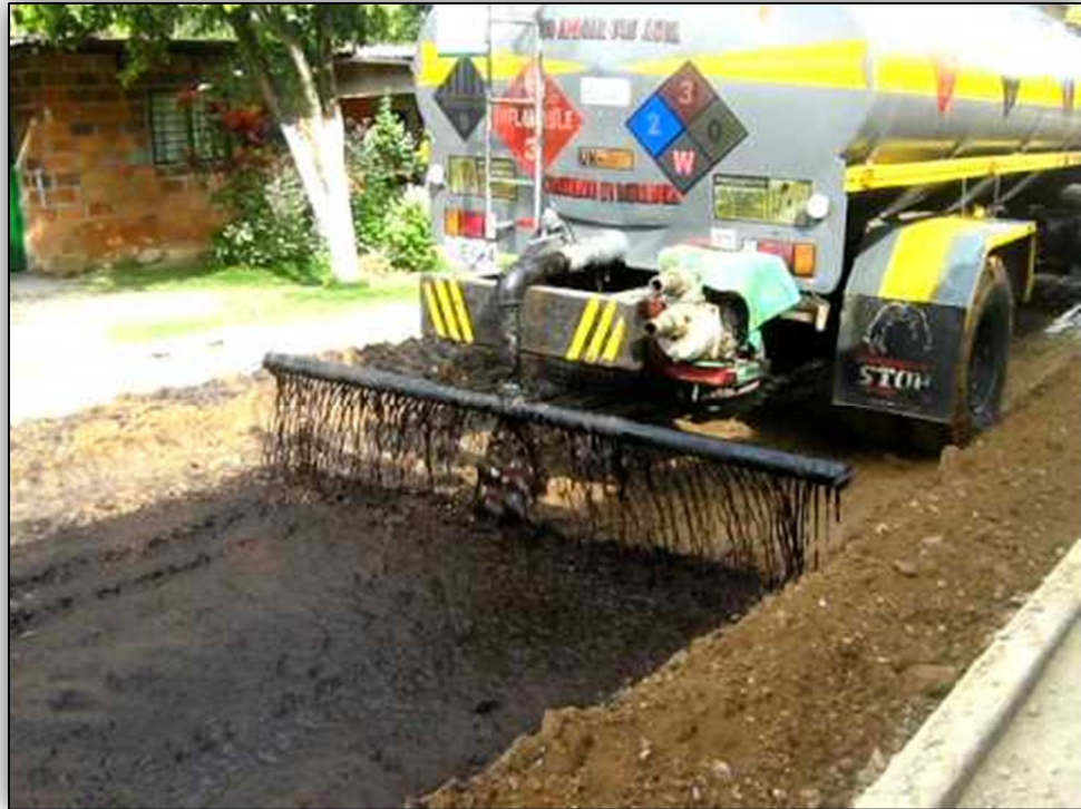
Figura 3.9 Estabilización de capa base con emulsión asfáltica cortesía de www.osusa.com
