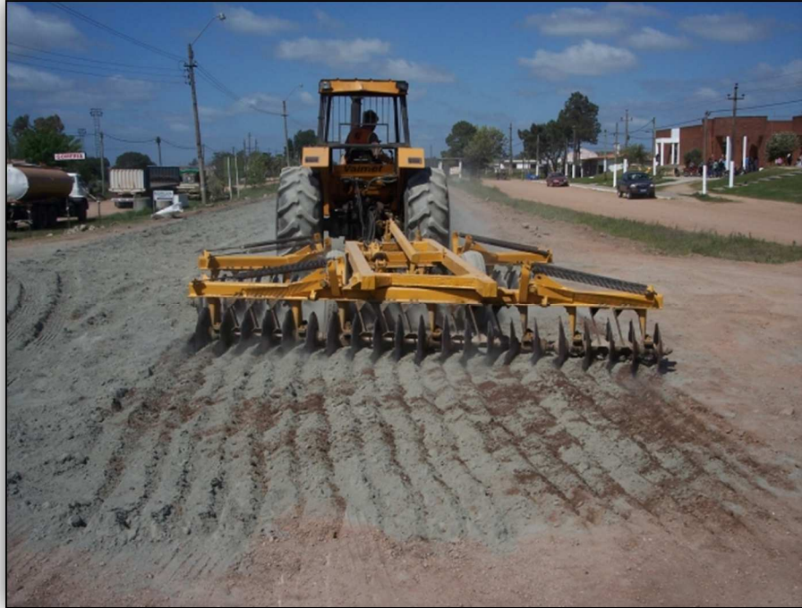
Figura 3.5 Estabilización de capa base con cemento Portland cortesía de www.osusa.com
