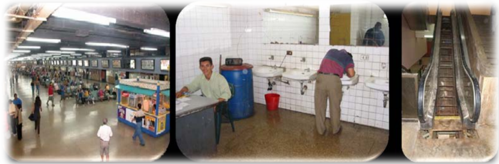
Figura 3 Terminal Terrestre de Guayaquil antiguo
