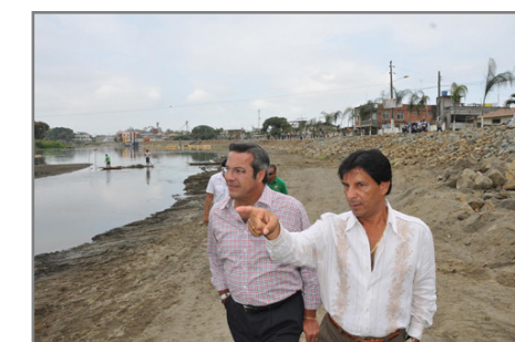
GRÁFICO 7: AUTORIDADES INSPECCIONANDO AVANCES DE CONSTRUCCIÓN DE MUROS DE CONTENCIÓN Fuente: http://revistabuscandolanoticia.com/salitre.html
