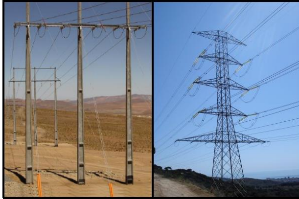
Figura 2.9: Estructuras tipo anclaje
