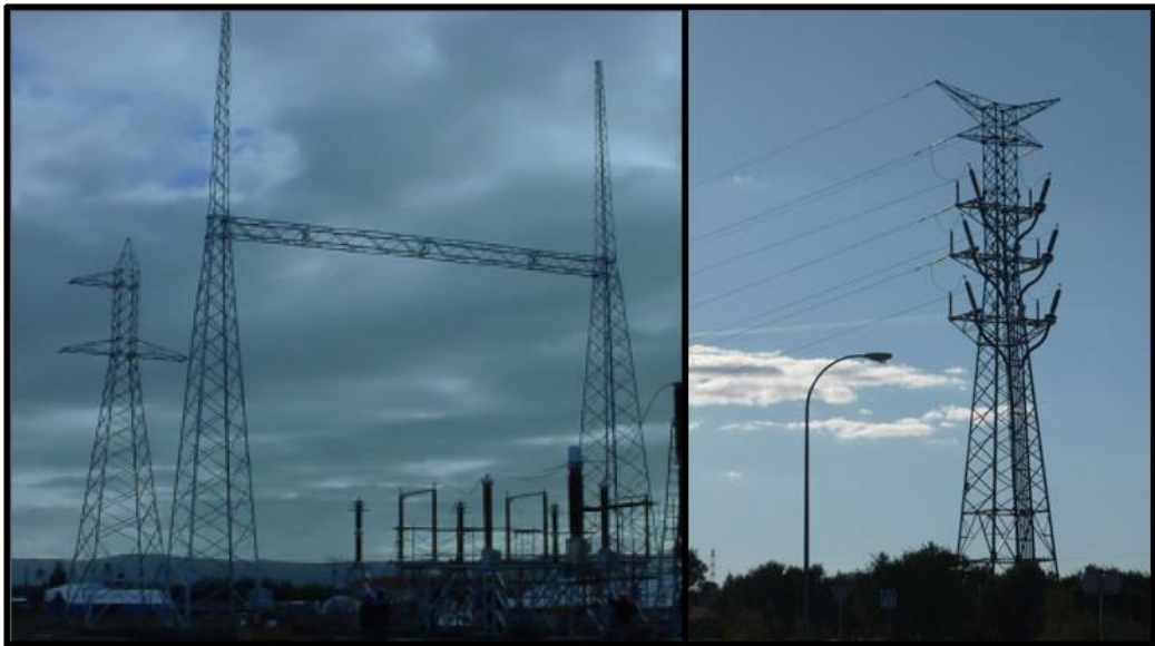
Figura 2.10: Estructuras tipo Terminal y Remate
