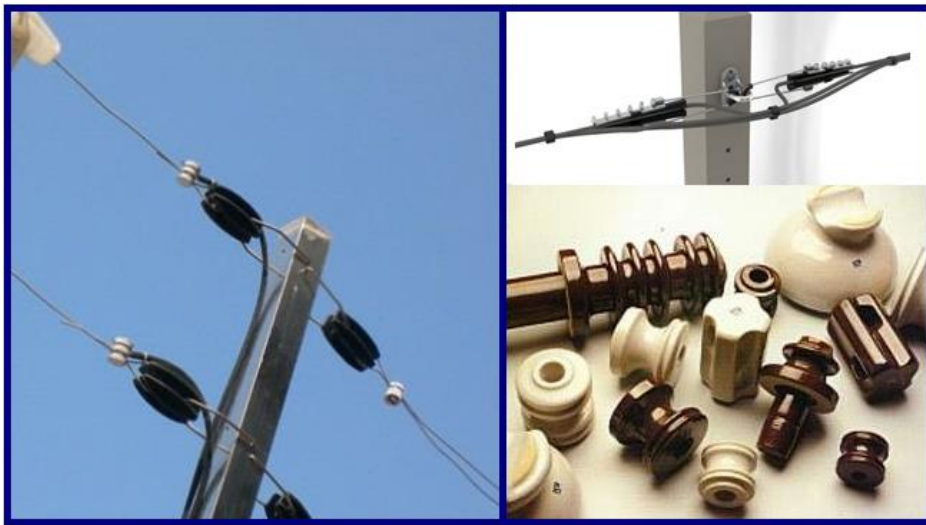
Figura 2.19: Aisladores de tracción
