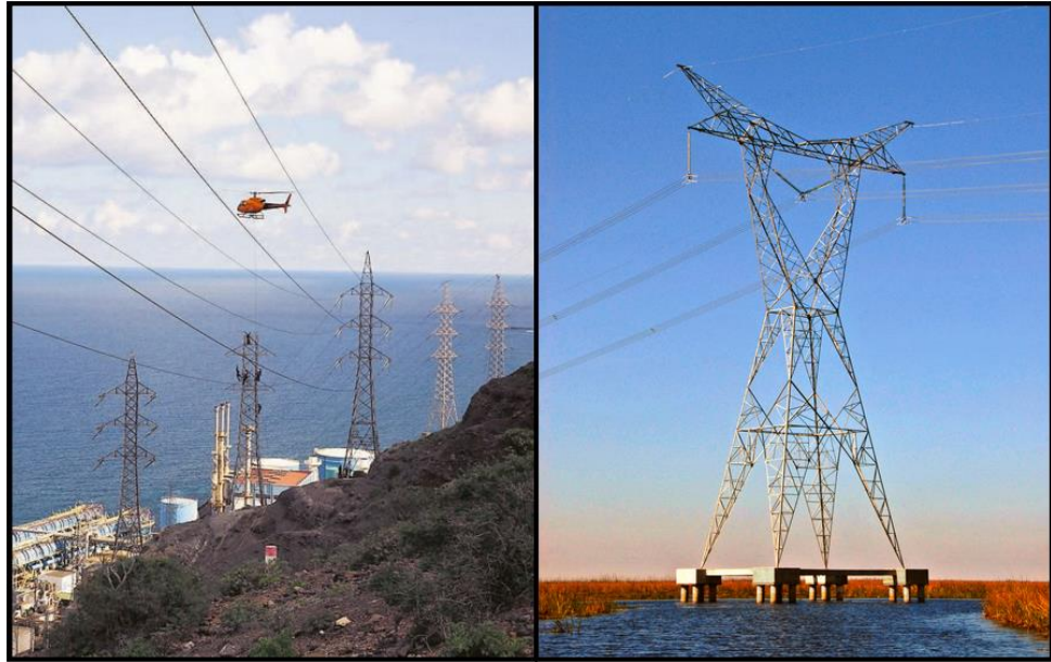
Figura 2.11: Estructuras tipo Especial
