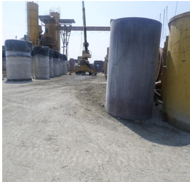
ILUSTRACIÓN 24 PROCESO LLENADO DE MOLDE
