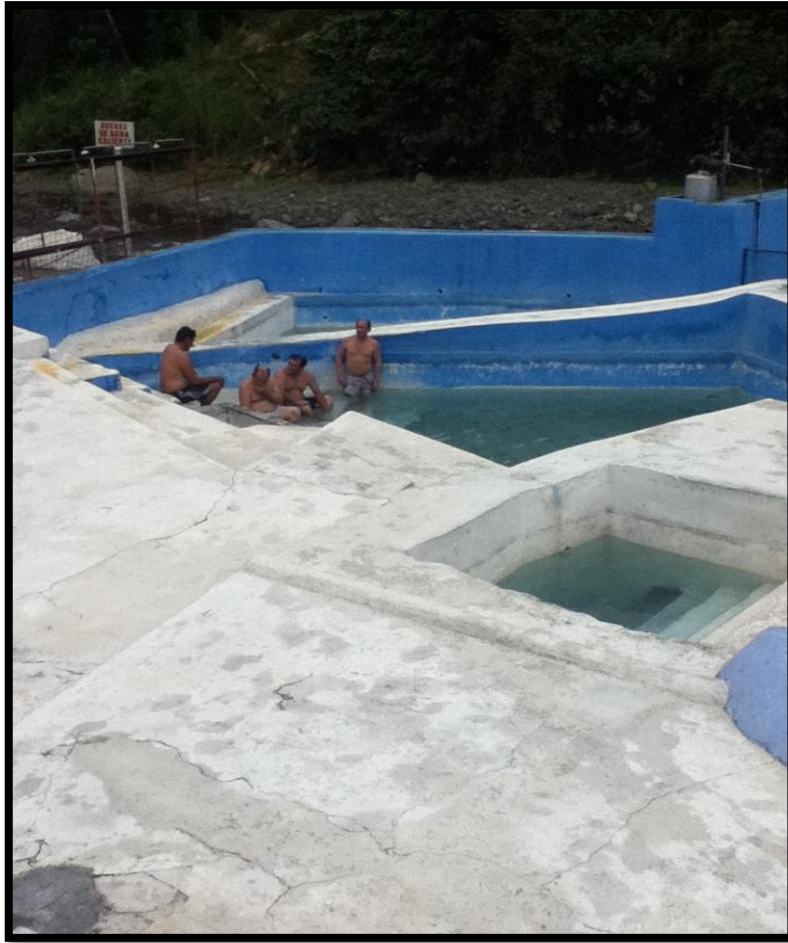
Foto# 41: Visitantes en las piscinas de agua termal Elaboración: Autor del Proyecto
