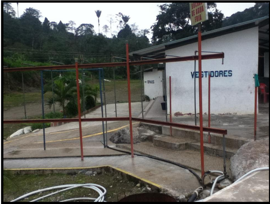
Figura# 39: Duchas de agua fría del balneario Elaboración: Autor del Proyecto
