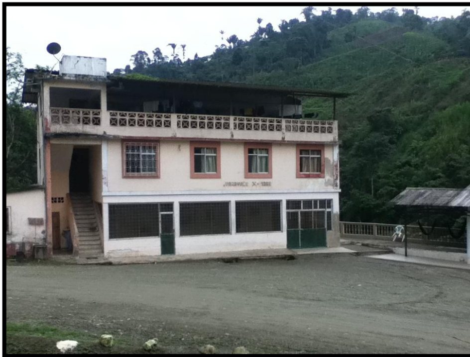
Figura# 32: Infraestructura actual del balneario Elaboración: Autor del Proyecto
