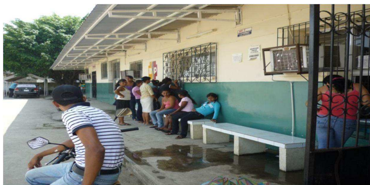
Foto 3.1.- Fachada principal del H.C. Dr. Juan Montalván Cornejo. Fuente: Autor
