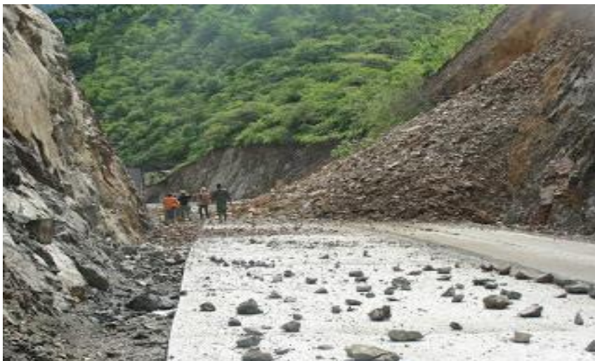
Imagen 6. Loja: deslaves interrumpen el paso en la vía El Empalme-Celica Fuente: http://careitv.blogspot.com . 2012
