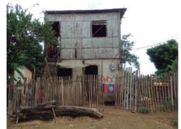
Imagen 12. Vivienda ubicada en la zona rural de la cabecera cantonal.
