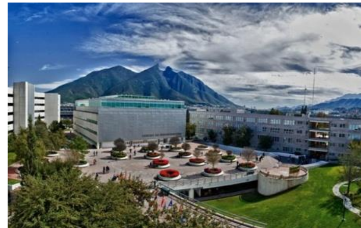
Imagen 43 Vista exterior del edificio
