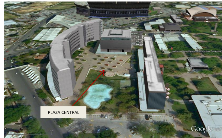
Imagen 46. Vista aérea del ingreso principal.
