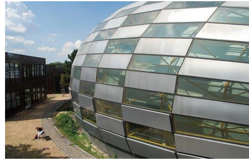
Imagen 73. Vista exterior del edificio, detalle del revestimiento
