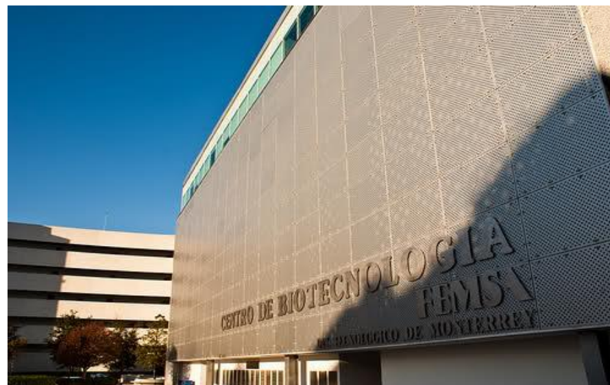
Imagen 45. Detalle del ingreso al edificio.
