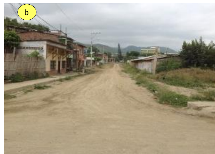
Imagen 5. Vista general de la calle Gonzalo Suarez.
