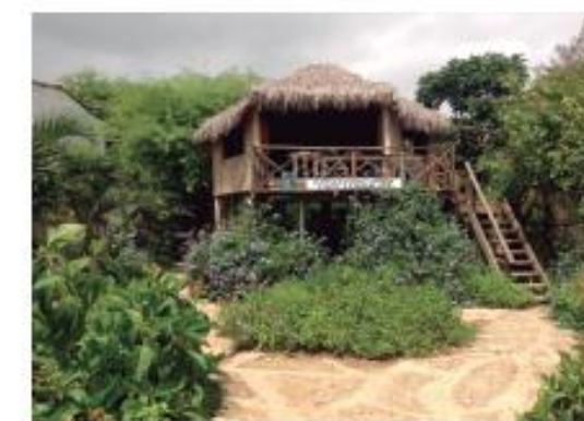
Imagen 6. Construcción en Bambú, Cafetería
