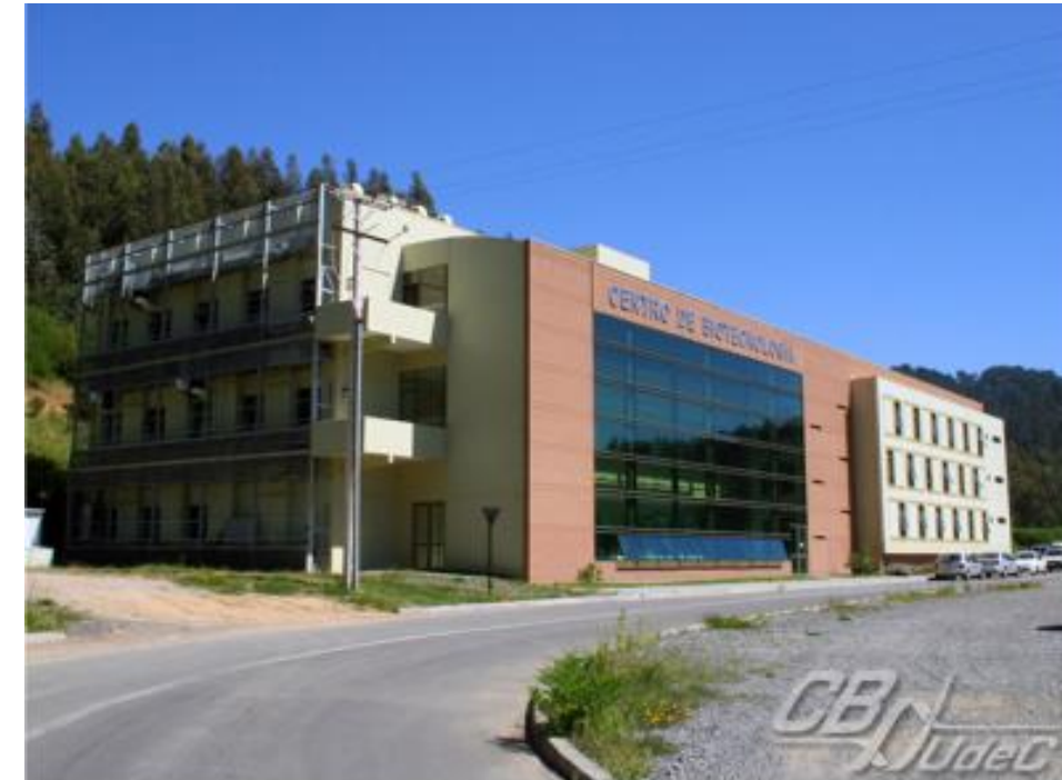
Imagen 40. Vista lateral izquierda del edificio.
