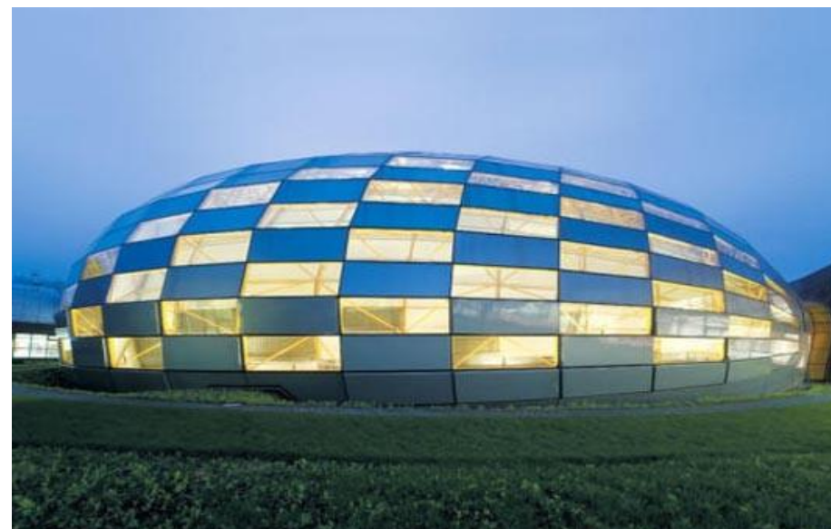
Imagen 66. Vista lateral del edificio
