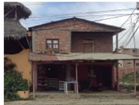
Imagen 15. Vivienda de bloque.
