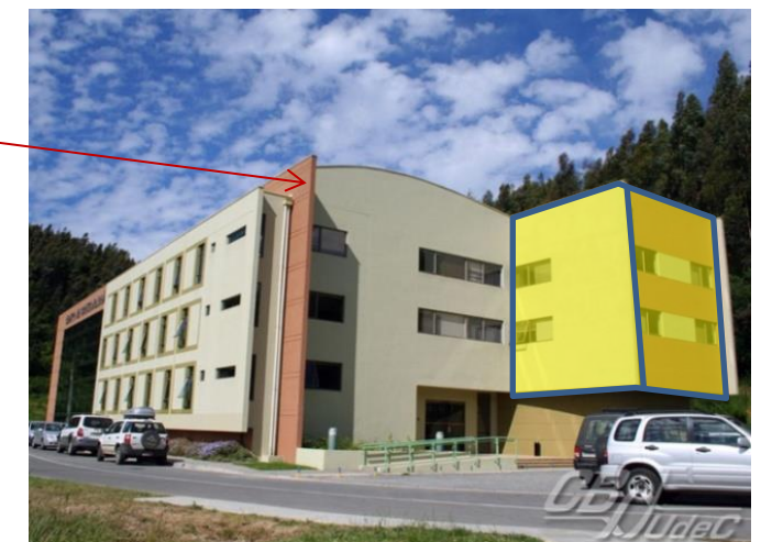
Imagen19. Vista lateral derecha del edificio
