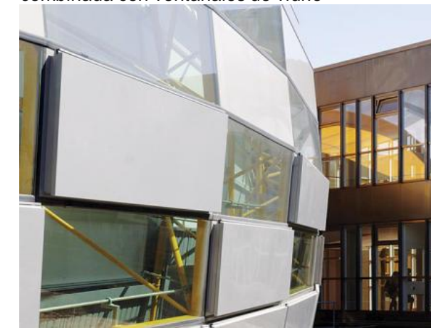
Imagen 75. Detalle de los paneles de alucobond combinada con ventanales de vidrio
