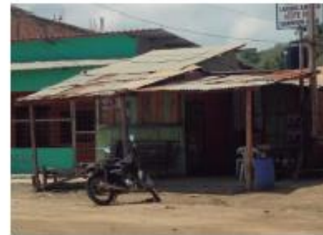
Imagen 14. Vivienda con cubierta de Zinc
