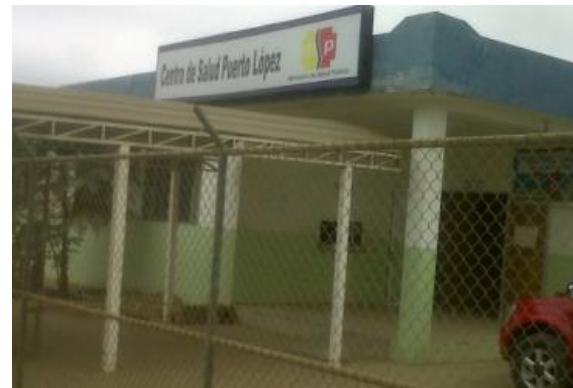
Imagen 1. Centro de Salud de la Parroquia Puerto López Fuente: Grupo de Trabajo de Titulación de Arquitectura, 2013
