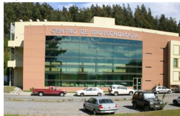
Imagen 18. Vista frontal del edificio.
