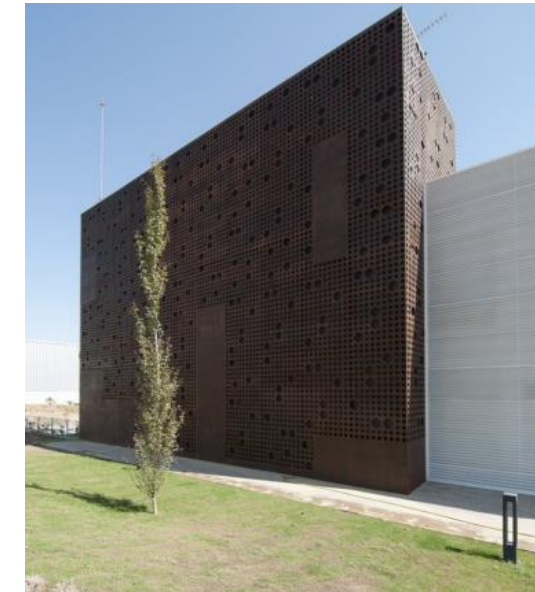
Imagen 62. Vista lateral del edificio
