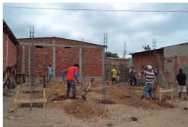
Imagen 2. Construcción de Viviendas Sociales
