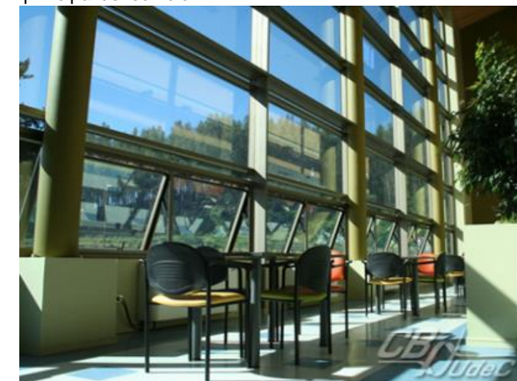
Imagen 41. Vista interior del edificio, Se pueden apreciar las columnas metálicas que forman parte de la fachada principal del edificio..
