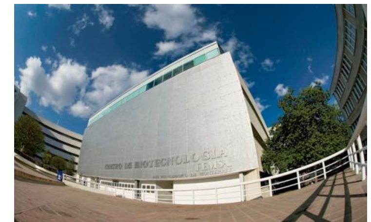
Imagen 44. Ingreso principal al Edificio de Biotecnología
