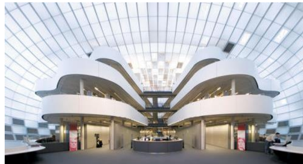
Imagen 68. Vista interior del edificio
