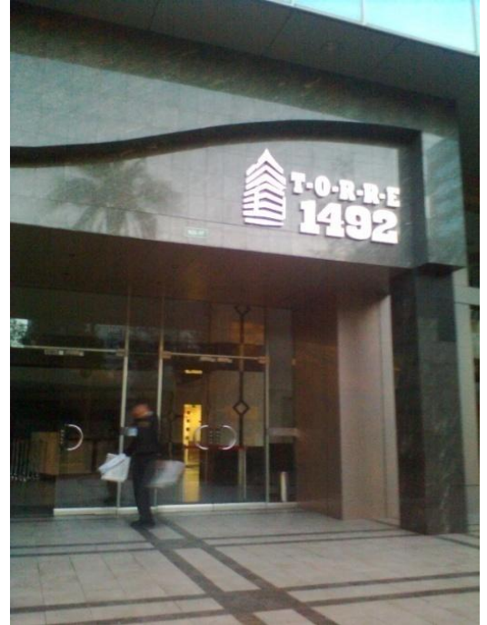
Foto ingreso al edificio donde opera la Oficina en Quito Elaborado por: Las Autoras enero 2.011
