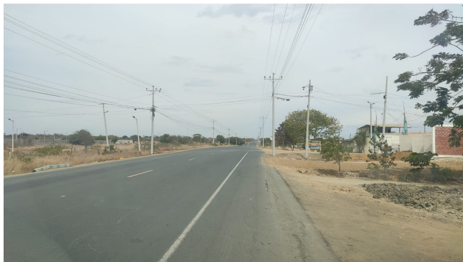
Figura 48. Via Data pavimentada en Posorja. Fuente: Elaboración propia (2024).
