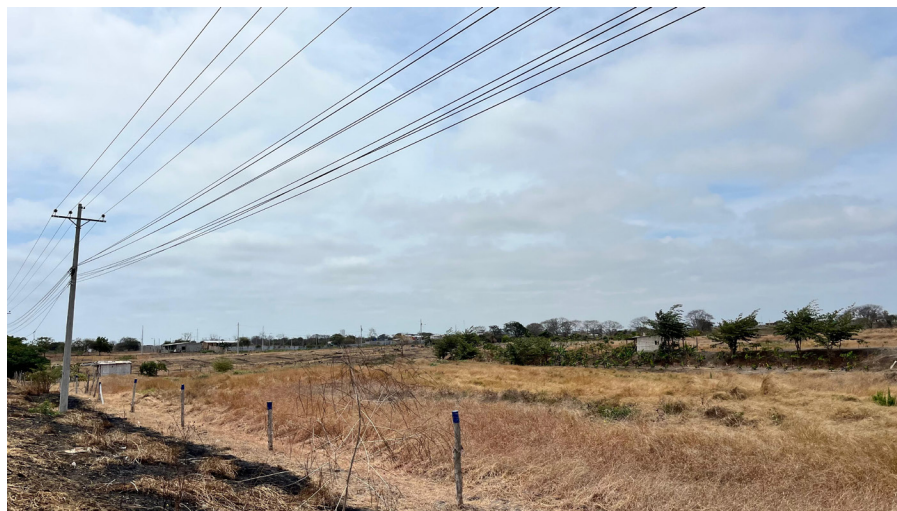
Figura 50. Vista del terreno a trabajar. Fuente: Elaboración propia (2024).
