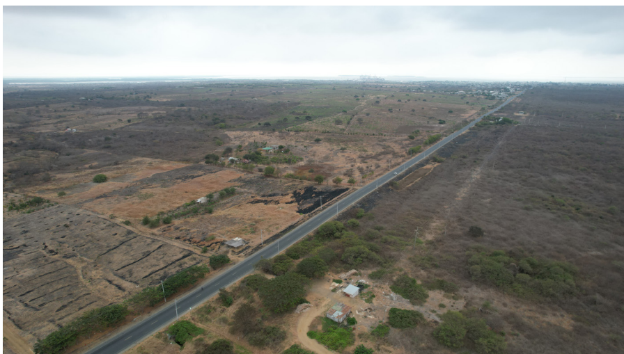
Figura 63. Toma con dron con la Vía Principal (Vía Data). Fuente: Elaboración propia (2024).
