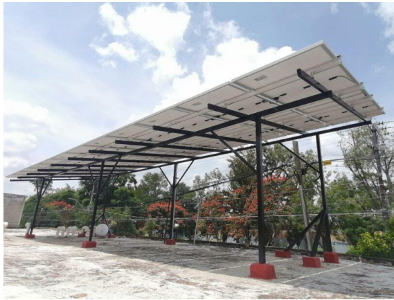
Figura 2-18 Estructura de instalación para módulos fotovoltaicos.
