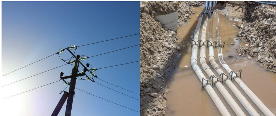
Figura 2-2 Acometida aérea y subterránea.
