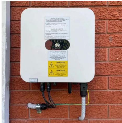
Figura 2-24 Inversor con controlador de carga Huawei.
