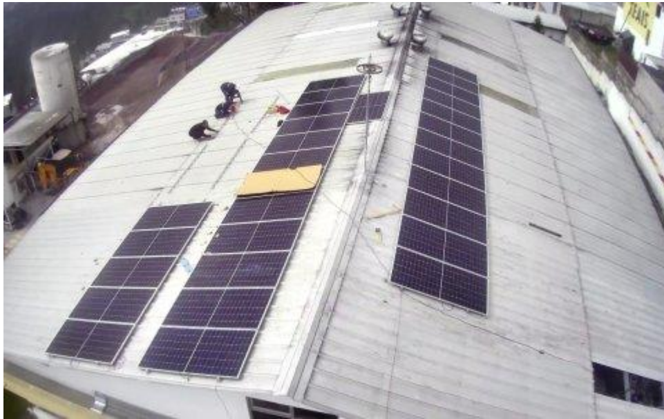
Figura 2-26 Instalación de módulos fotovoltaicos.
