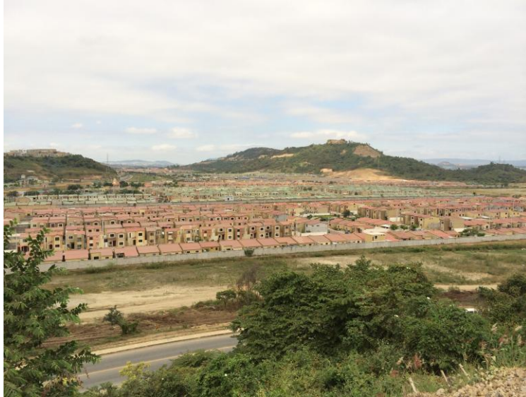
Foto 1. Viviendas Urb. Villa Club
