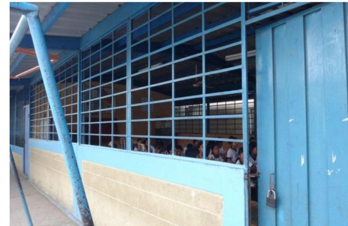
**Figura 6: Boquetes con rejas metálicas**
