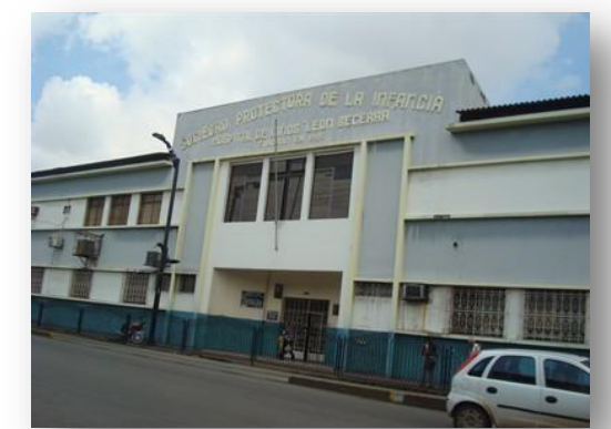
Figura 11: Fachada lateral del Hospital León Becerra. Fuente: Diario Extra (2012)
