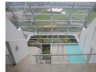
Figura 12: Vista desde el interior de la casa. Fuente: ESPOL (2010)
