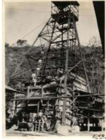
Figura 3. Pique "Americano" de la SADCo. Simbolo de Portovelo hasta el 2000, fecha en que se destruyó
