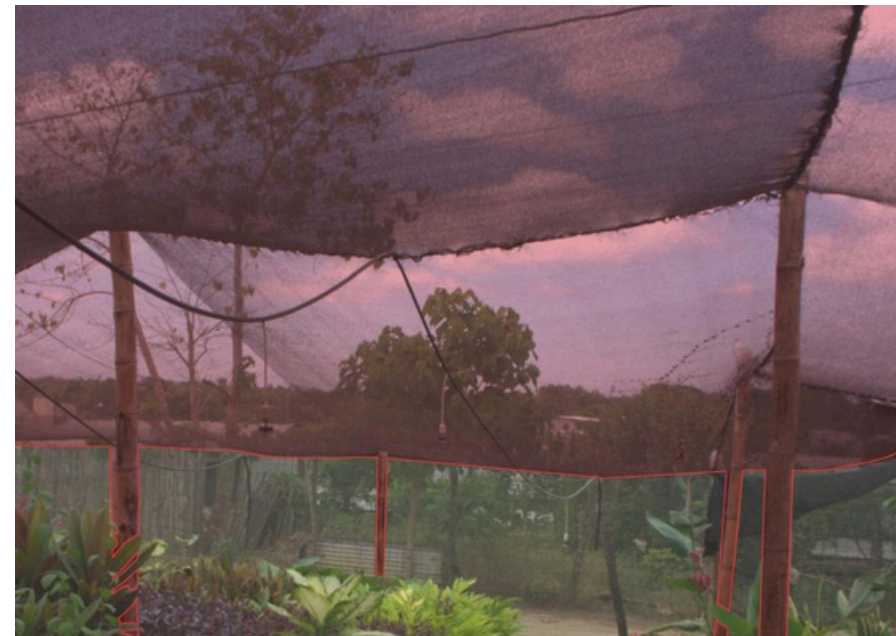
Figura 4. Malla de Gallinero y Estructura sin Normativa de Caña. Fotografía de Autoría Propia.
