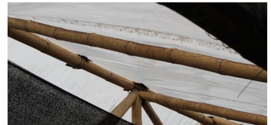
Figura 71. Fotografía Generación de Moho en Plástico y geomalla en Vivero Árborea. Autoría Propia.
