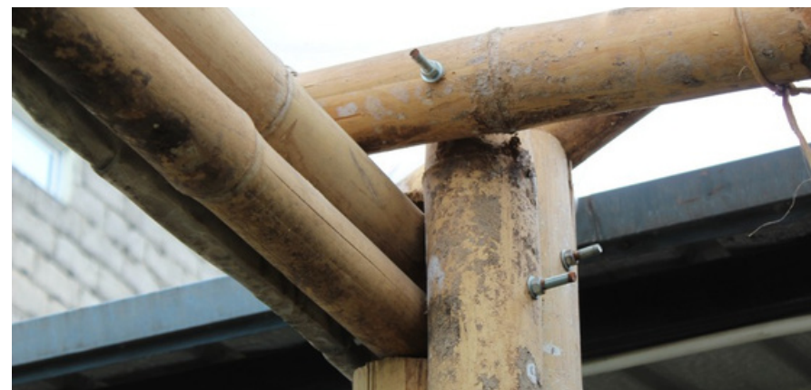
Figura 70. Fotografía Solución Pernada en Vivero Árborea. Autoría Propia.
