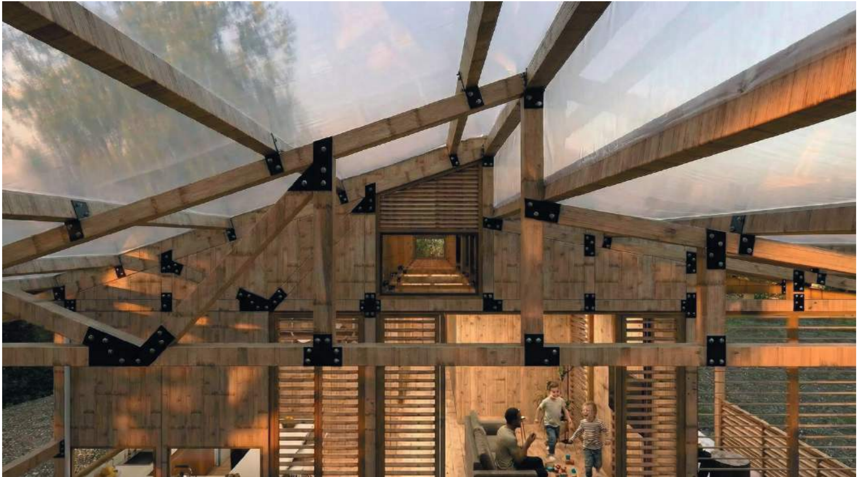
DETALLE DE ESTRUCTURA DE CUBIERTA DE ÁREA PRODUCTIVA
