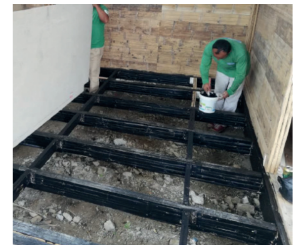
Aplicacion de cemento asfaltico como impermeabilizante en la viga PLASBAM Fuente: Construcciones sostenibles de bambu,(2021)
