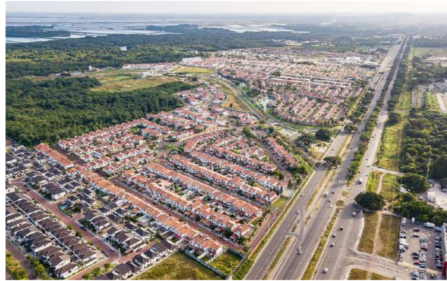
Imagen 5: Fotografía área de la urbanización Terranostra (Etinar, 2024)
