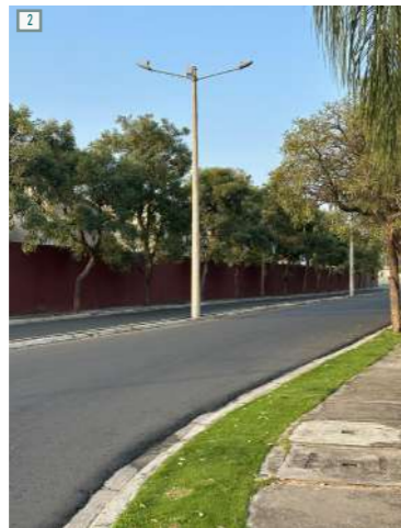
Imagen 8: Tramo de la calle (2025)
