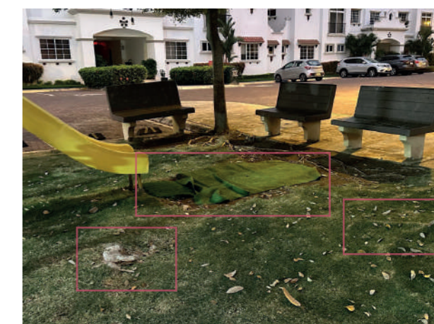
Anexo 13: Deterioros y desniveles en el suelo (Elaboración propia, 2025)
