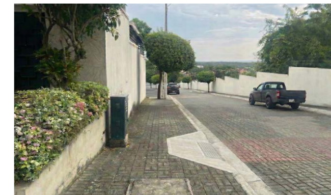
Imagen 18. Implementación de rampas.
