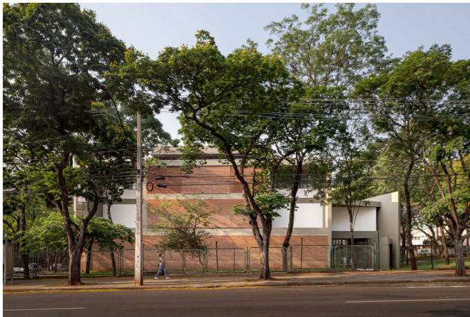
Figura 50. Edificio administrativo de la Universidad Estatal de Maringá y Agencia bancaria. Fuente: https://acortar.link/9IL6bT
