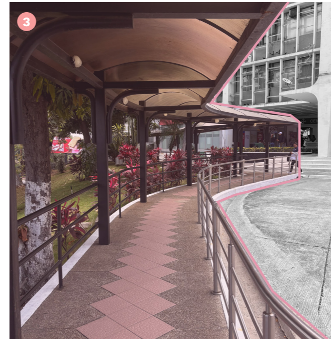
Figura 8. Circulación hacia Facultad de Artes y Humanidades. Fuente: Elaboración propia.
