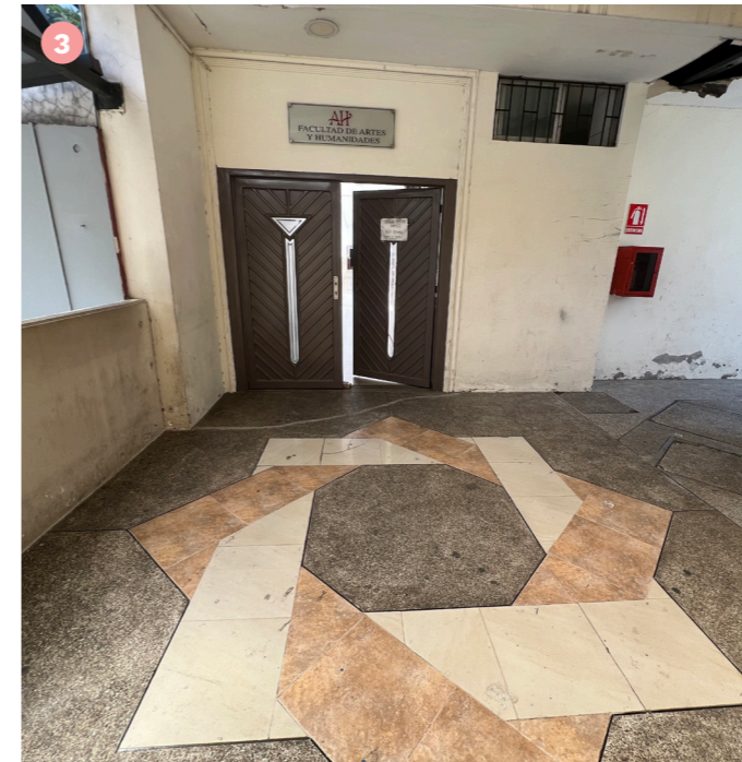
Figura 37. Puerta de ingreso a la planta alta 2. Fuente: Elaboración propia.
