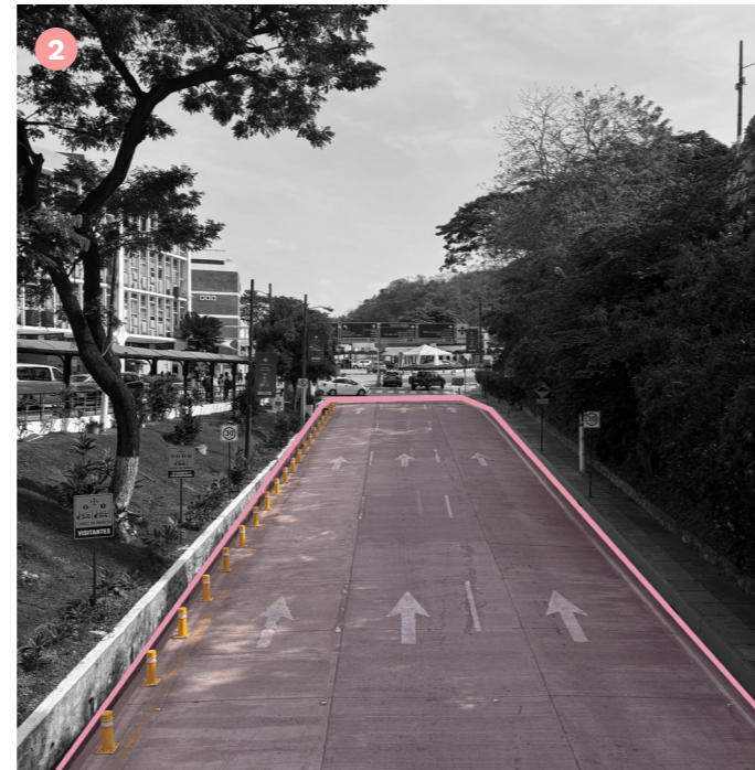
Figura 7. Ingreso vehicular UCSG. Fuente: Elaboración propia.
