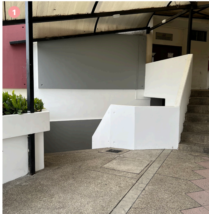
Figura 23. Ingreso a planta alta 1. Fuente: Elaboración propia.
