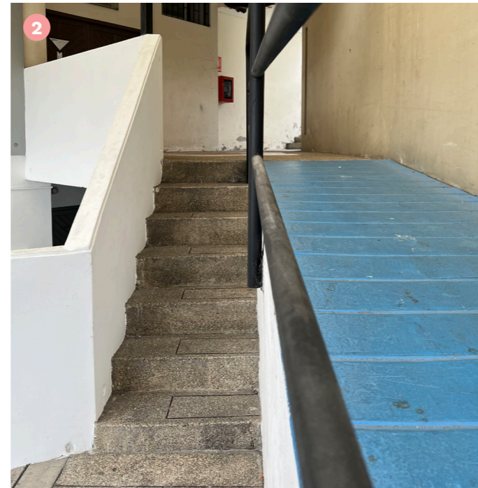
Figura 36. Rampa y escalera de ingreso. Fuente: Elaboración propia.
