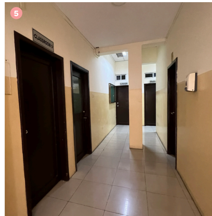
Figura 28. Columna ubicada en el centro del pasillo. Fuente: Elaboración propia.
