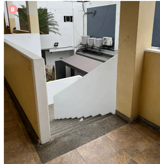
Figura 33. Escalera (integrada cuando el edificio se convirtió en Centro de Idiomas) que conecta con la planta baja. Fuente: Elaboración propia.
