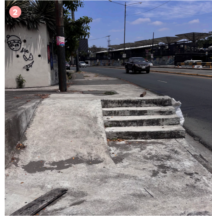
Figura 16. Acceso discapacitados. Fuente: Elaboración propia.
