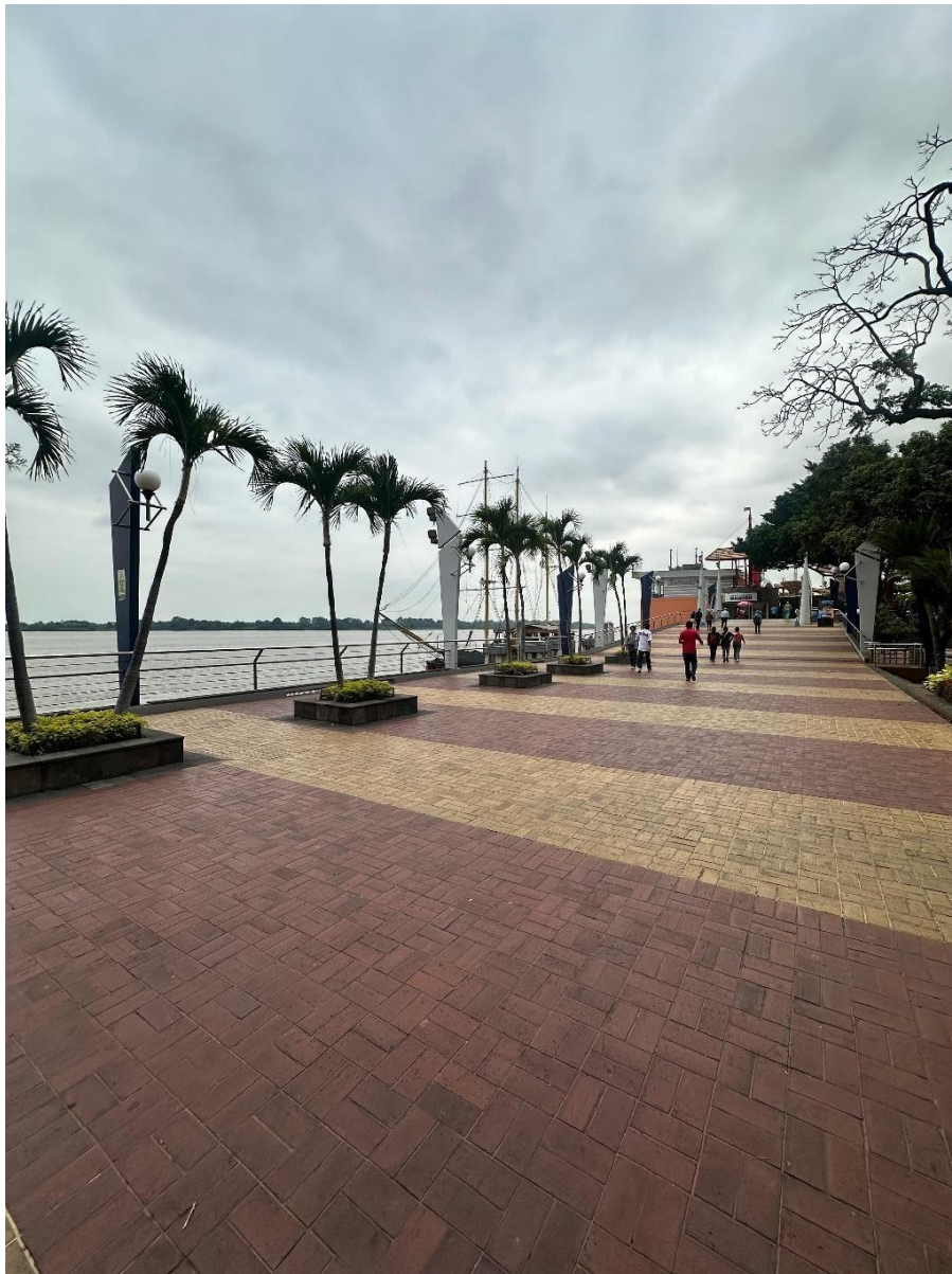
Imagen 21: Fotografía del estado actual del Malecón. Tomada por autora.
