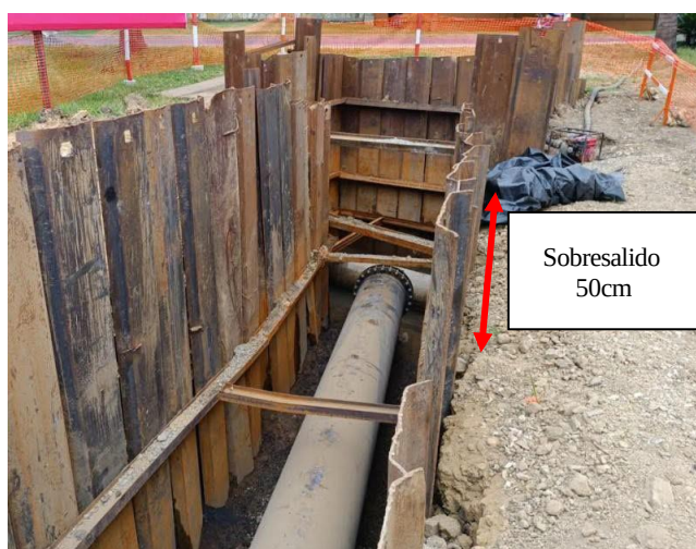
Figura 14. Entibado doblemente arriostrado sobresalido en 50 cm desde el nivel de la rasante.
