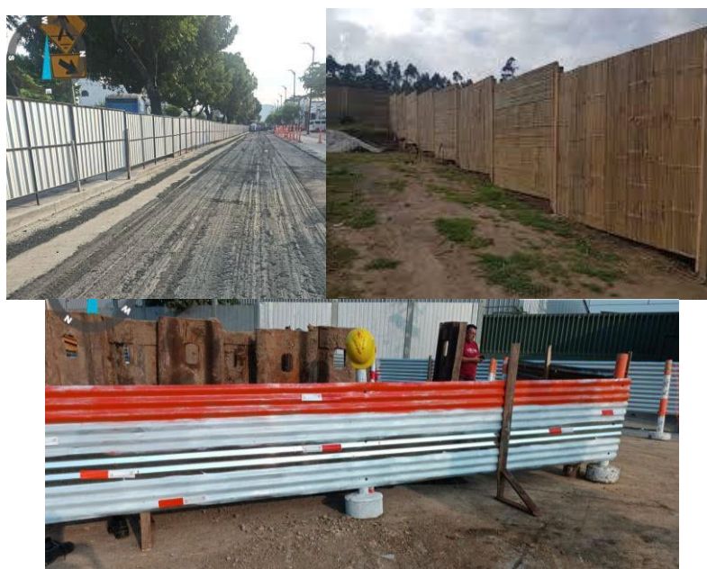
Figura 17. Ejemplo de cerramiento de zinc y de cañas
