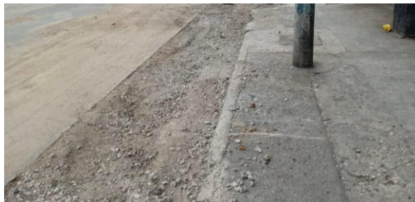
Figura 1. Ejemplo del relleno a nivel de rasante
