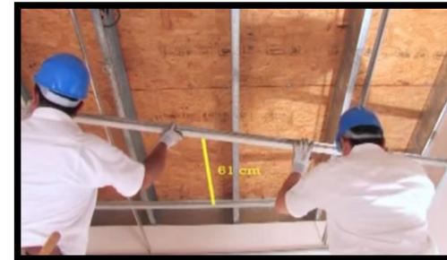
**Figura 52:** Instalación de gypsum
