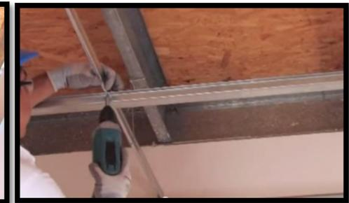
**Figura 53:** Instalación de gypsum
