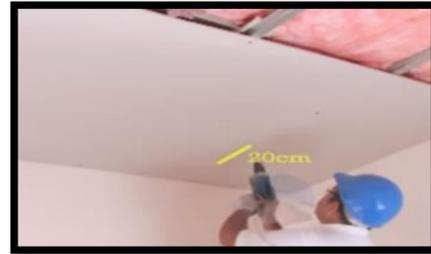
**Figura 66:** Instalación gypsum
