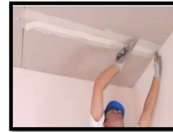
**Figura 6970:** Instalación gypsum
