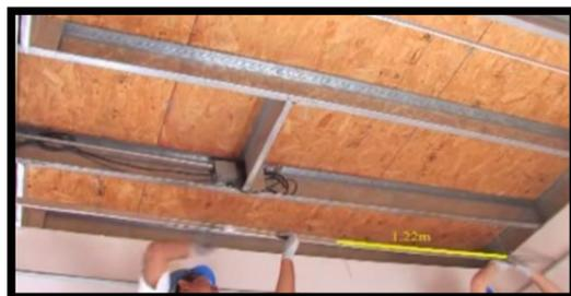
**Figura 51:** Instalación de gypsum
