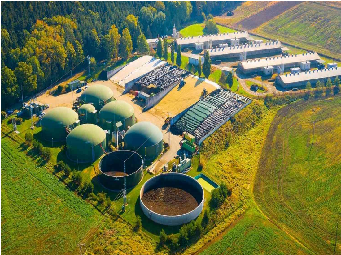
Figura 10. Central de generación con Biomasa
