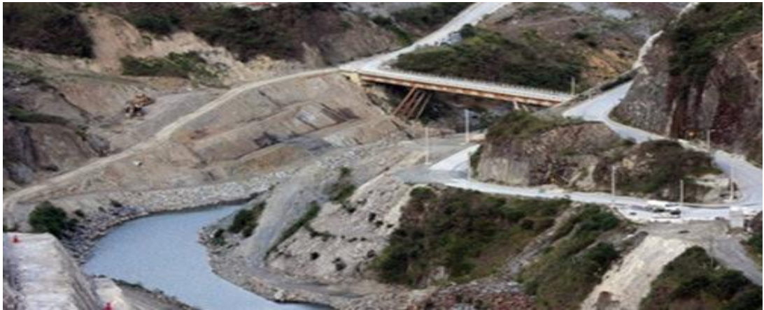
Figura 8. Central de generación hidroeléctrica
