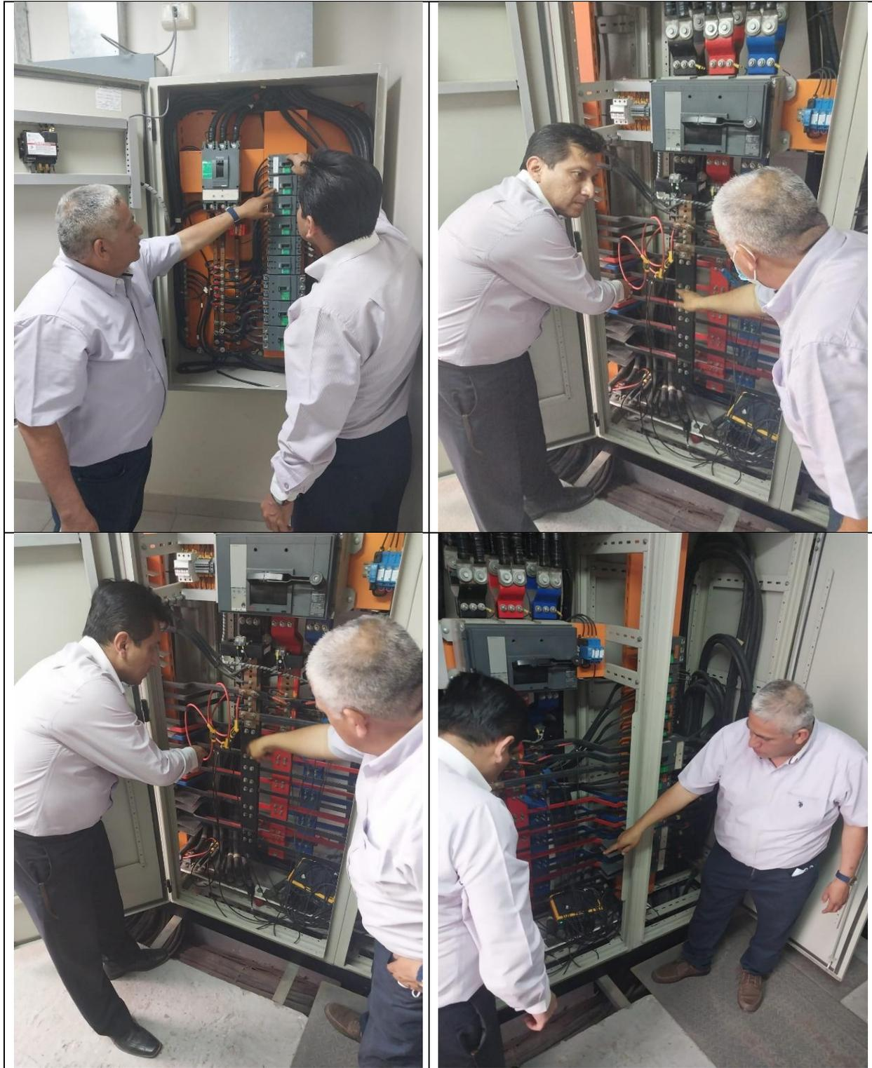
Supervisión, verificación de la instalación, y funcionamiento de equipos del Analizador de Redes, para la obtención de data, en la cual el equipo está programado para registrar parámetros en intervalos de cada 10 minutos.
