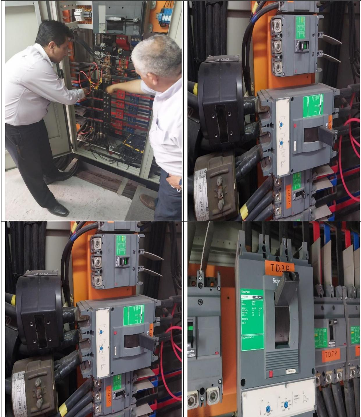
Ubicación del tablero principal de alimentación eléctrica a las diferentes áreas de la Gerencia General, en la cual, se tienen las protecciones principales, elementos de medición semi directa, como los transformadores de corriente, barras de distribución que es el sitio donde se instalan el equipo para el registro de muestras de parámetros para obtener cantidades de energía o consumo, así como la demanda eléctrica
