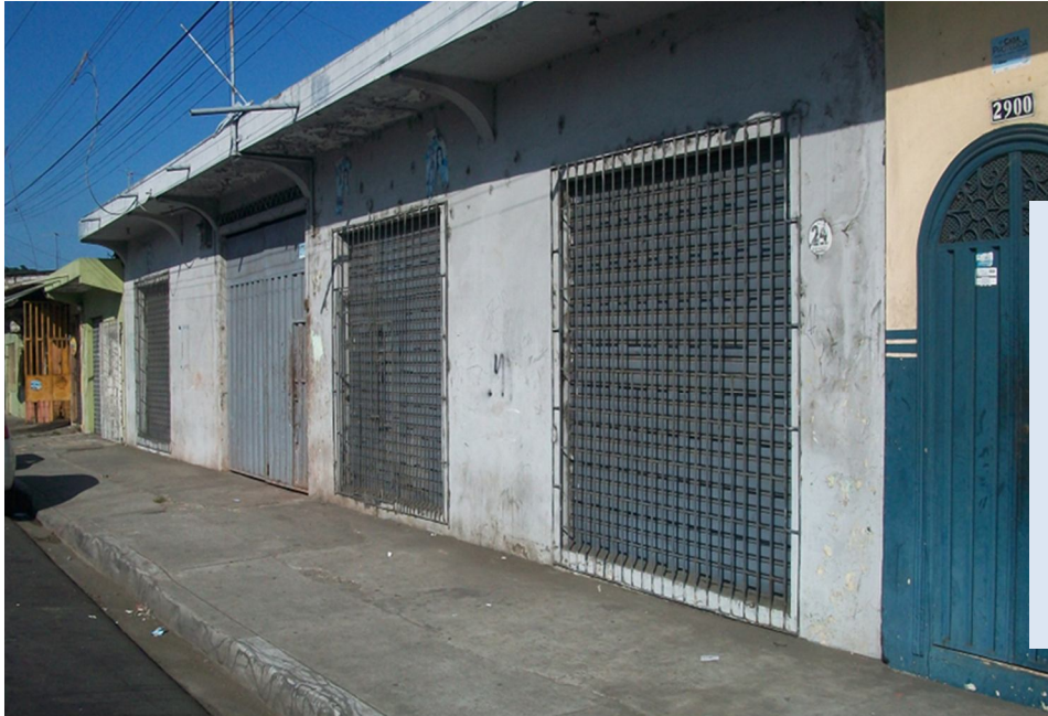
Figura N°5 Área de Bodegas
