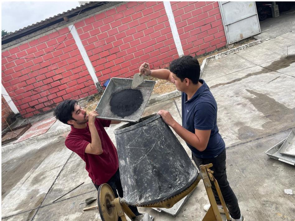
Ilustración 31: Adición de biocarbón de café a la mezcladora de hormigón. Fuente: elaboración propia.
