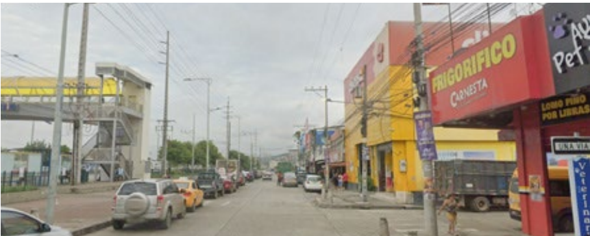
Imagen 18. Vista B calle 9 de octubre - Vista paso peatonal elevado Fuente: Google Maps
