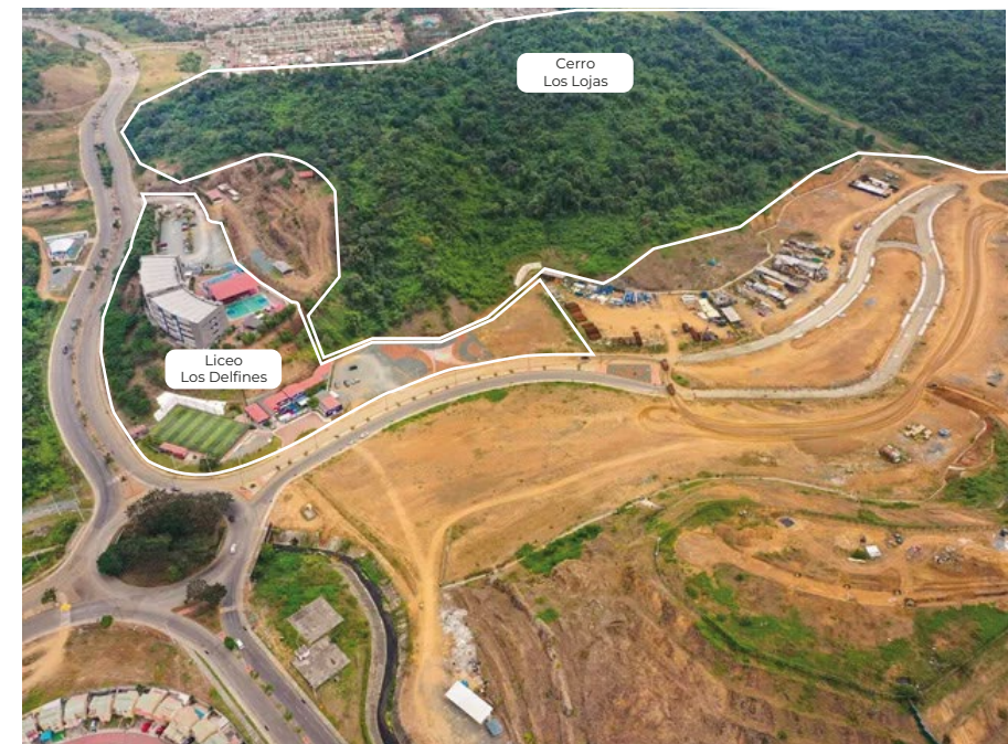
Imagen 4. Proceso constructivo de urbanización Villa del Rey Fuente: www.properati.com.ec
