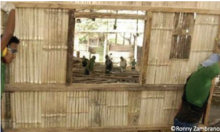
Figura 13. Materiales ligeros y estructura flexible, Fuente: (Ecuador – Costa, 2016)
