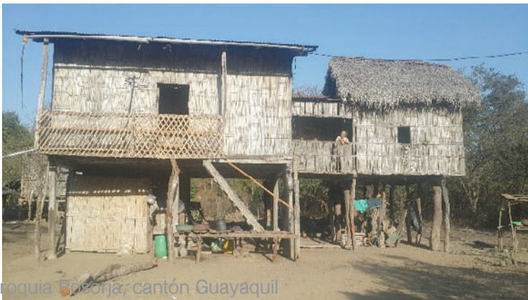
Figura 13. Vivienda de tres espacios. Las Chacras, Portoviejo, Fuente: (Vista de la Vivienda de los Tres Espacios de Portoviejo Como Patrimonio Cultural de las Comunidades Rurales Manabitas / Módulo Arquitectura – CUC, s.f.)
