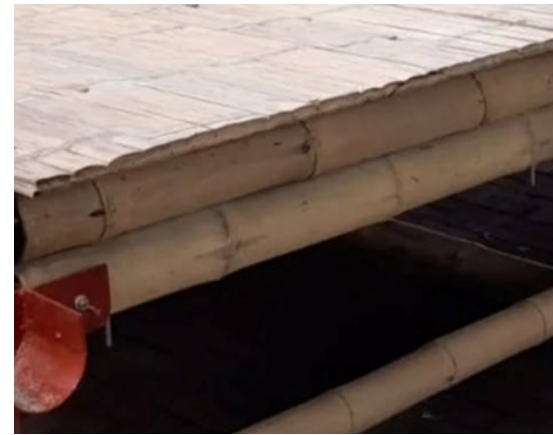
Imagen 16: Losa de entrepiso Plas-Bam tipo PB-003
