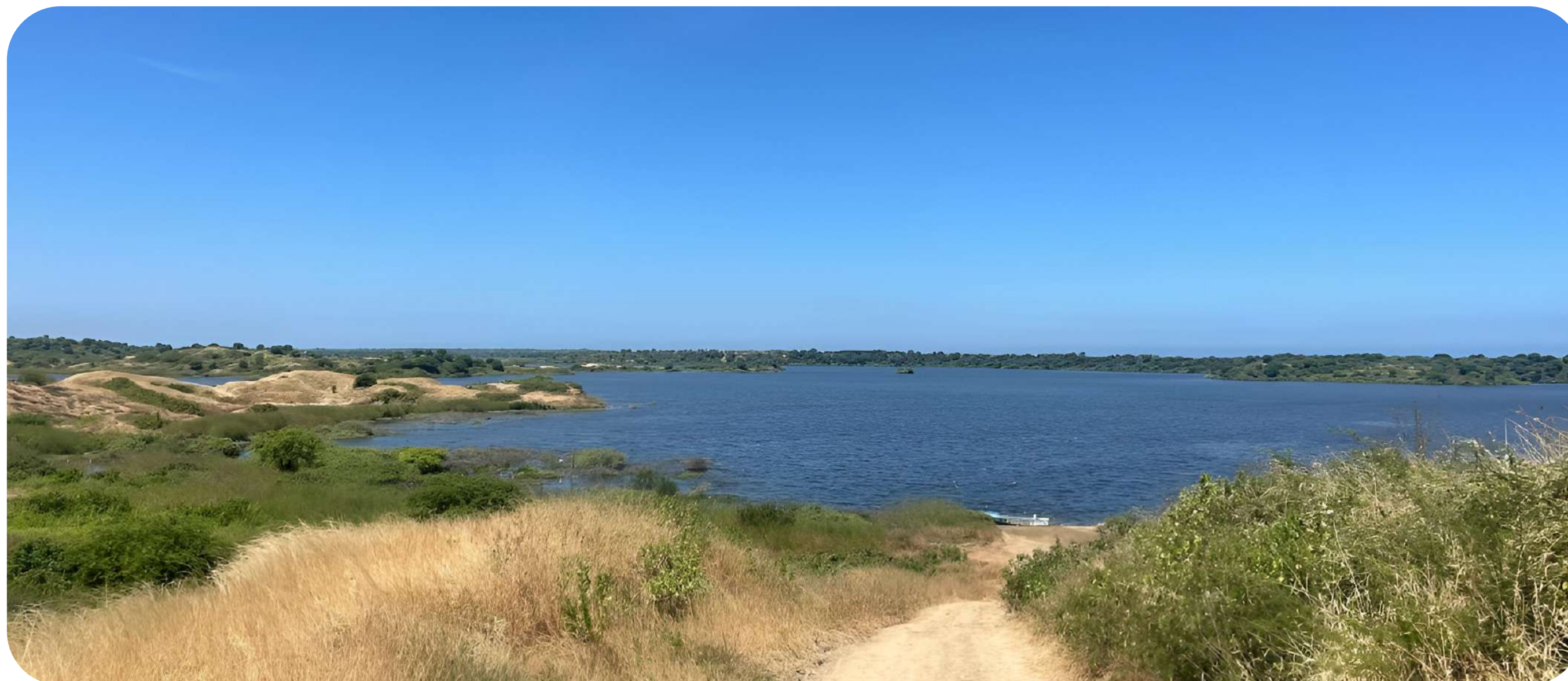
Figura 1: Vista panorámica de la represa Velasco Ibarra Elaboración propia
