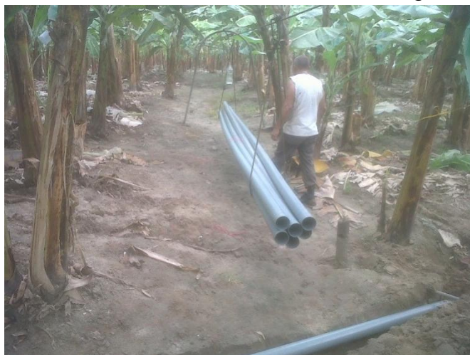
Gráfico 8: Construcción de Canal de Riego
