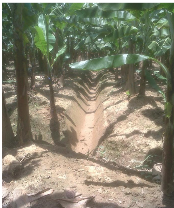
Gráfico 7: Construcción de Canal de Riego
