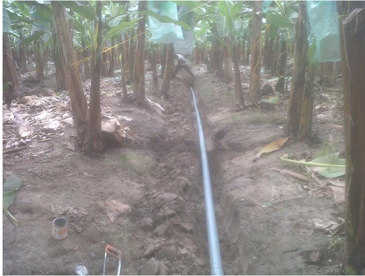
Gráfico 10: Construcción de Canal de Riego
