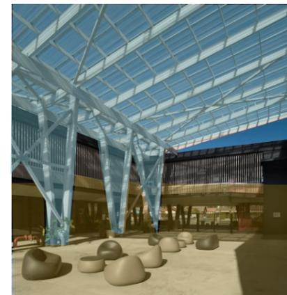
Estructuralmente, el primer nivel se resuelve en hormigón armado funcionando como base sólida. El segundo nivel, más liviano, construido en estructura metálica y ciertas áreas de listones de madera
