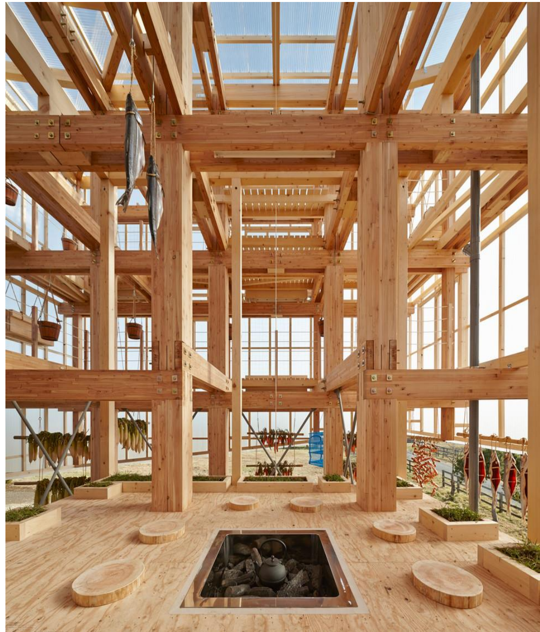
Ilustración 2 Sistema constructivo.- pórticos de madera.
