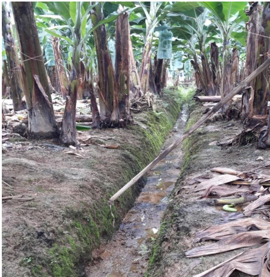
Foto 7. Canales de Drenaje
